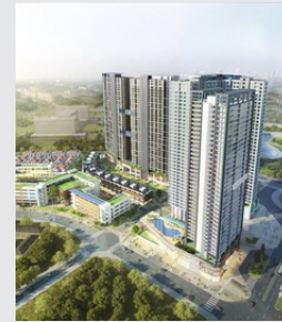
Dự án Golden Palace Mễ Trì Địa chỉ: Thành phố Hà Nội Sản phẩm: Giải pháp quản lý tòa nhà
