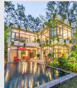
Dự án Biệt thự Flamingo Đại Lải Địa chỉ: Tỉnh Phú Thọ Sản phẩm: Hệ thống nhà thông minh
