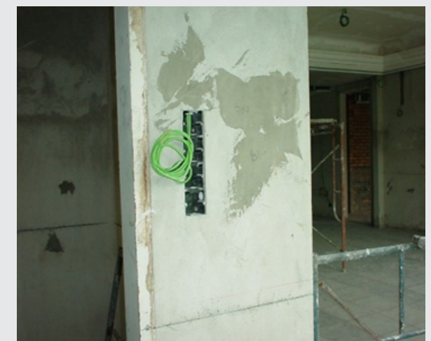
HỆ THỐNG ĐIỆN THÔNG MINH
